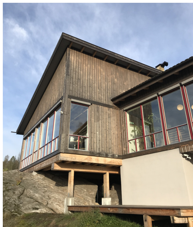
Ovan: Bild på kontorsbyggnaden tillhörande Hilmer Anderssons sågverk..
