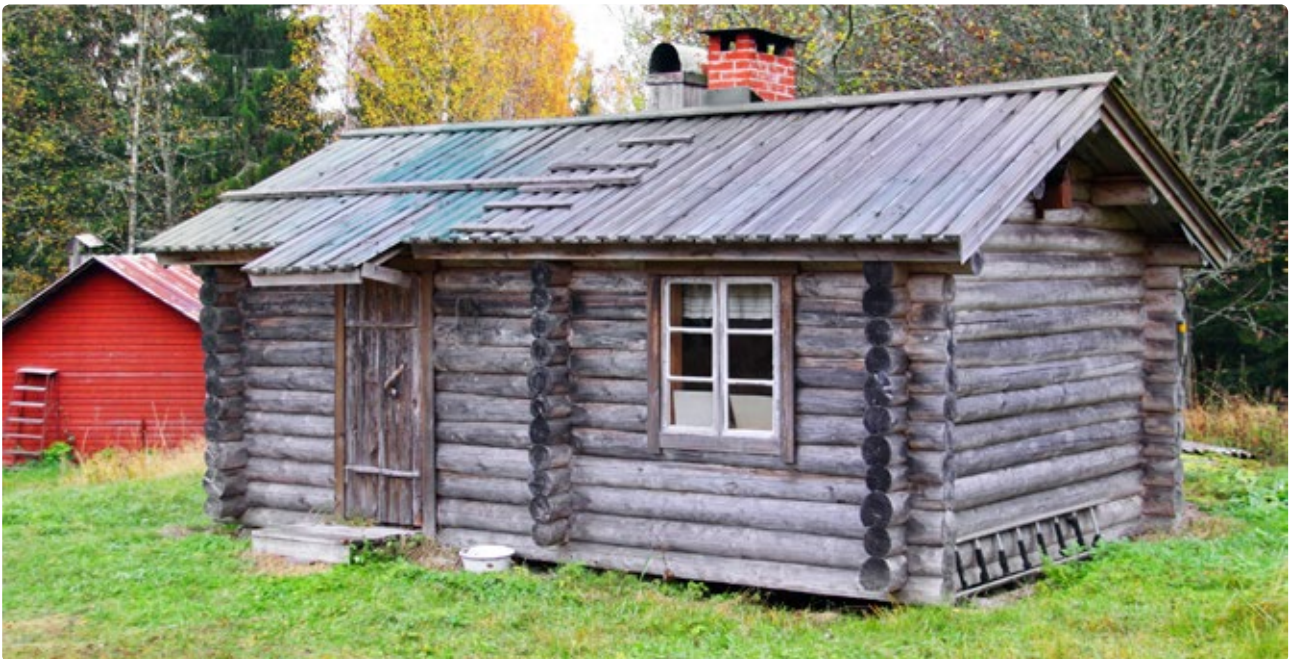
Wo einst der alte Holzschuppen aus dem 18. Jh. stand, wurde ein Blockhaus errichtet.
